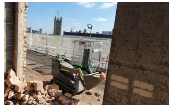
Construcción urbana / Demolición / Paisajismo
