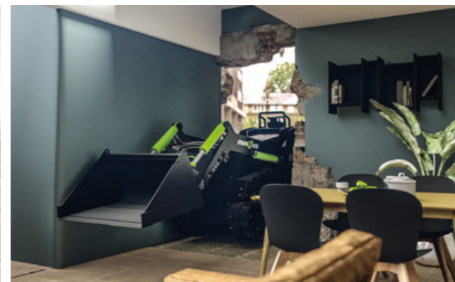
Construcción interior / Demolición
